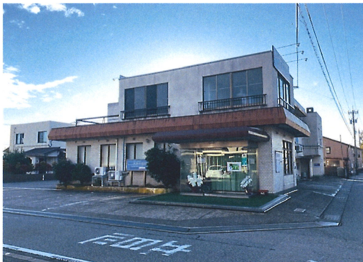
「取壊予定建物」
